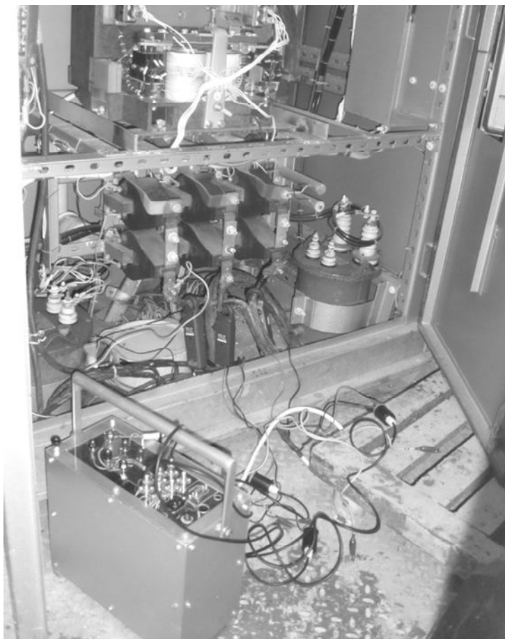
Рисунок 11 – Шафа електрорура і прилад для збору енергетичних параметрів ЕЛБ
