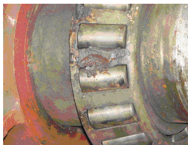
Рисунок 2 — Теплове заклинювання підшипника редуктора
