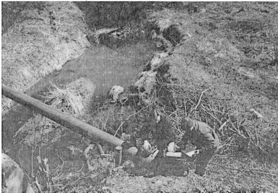
Рис. 4.3. Измерение величины коэрцитивной силы в кольцевом сварном соединении №1 газопровода Борислав – Дрогобыч на участке воздушного перехода через реку Вышницу
