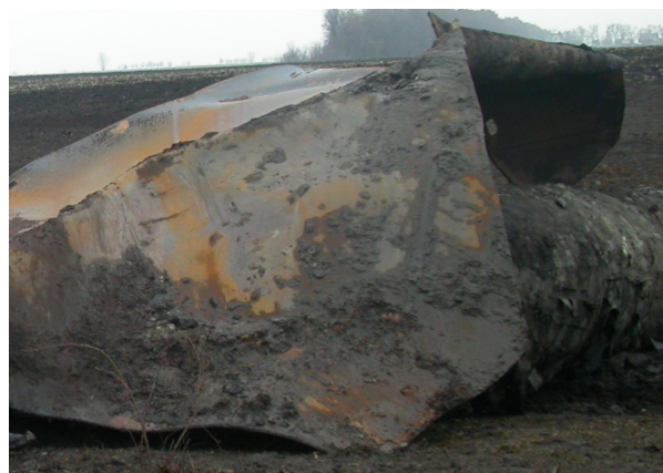
Рисунок 2 – Характерний приклад катастрофічного руйнування труби діаметром 1420 мм магістрального газопроводу “Уренгой–Помари–Ужгород” (2007 р. біля КС “Іллінці”)
