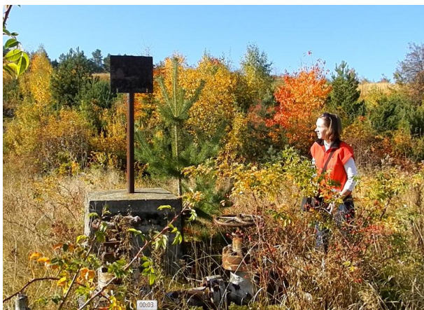
Рисунок 3.14 – Облаштування свердловин, що виведені з експлуатації а – законсервована свердловина з встановленою цементною тумбою; б – не законсервована свердловина, що виведена з експлуатації
