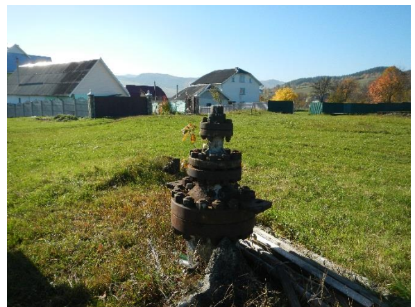
Рисунок 3.14 – Облаштування свердловин, що виведені з експлуатації а – законсервована свердловина з встановленою цементною тумбою; б – не законсервована свердловина, що виведена з експлуатації
