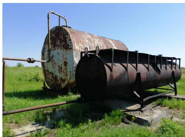
Рисунок 3.10 – Свердловина № 81-Вигода-Витвиця: а- облаштування свердловини; б - ємності для збору продукції свердловини № 81-Вигода-Витвиця
